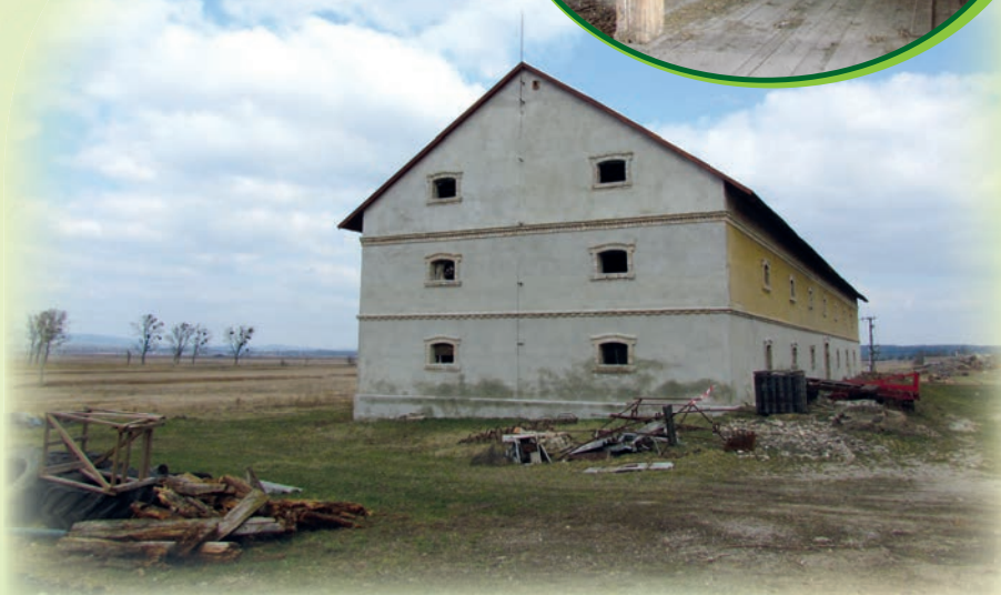
Un hambar sub renovare în Parcul natural Vértes
